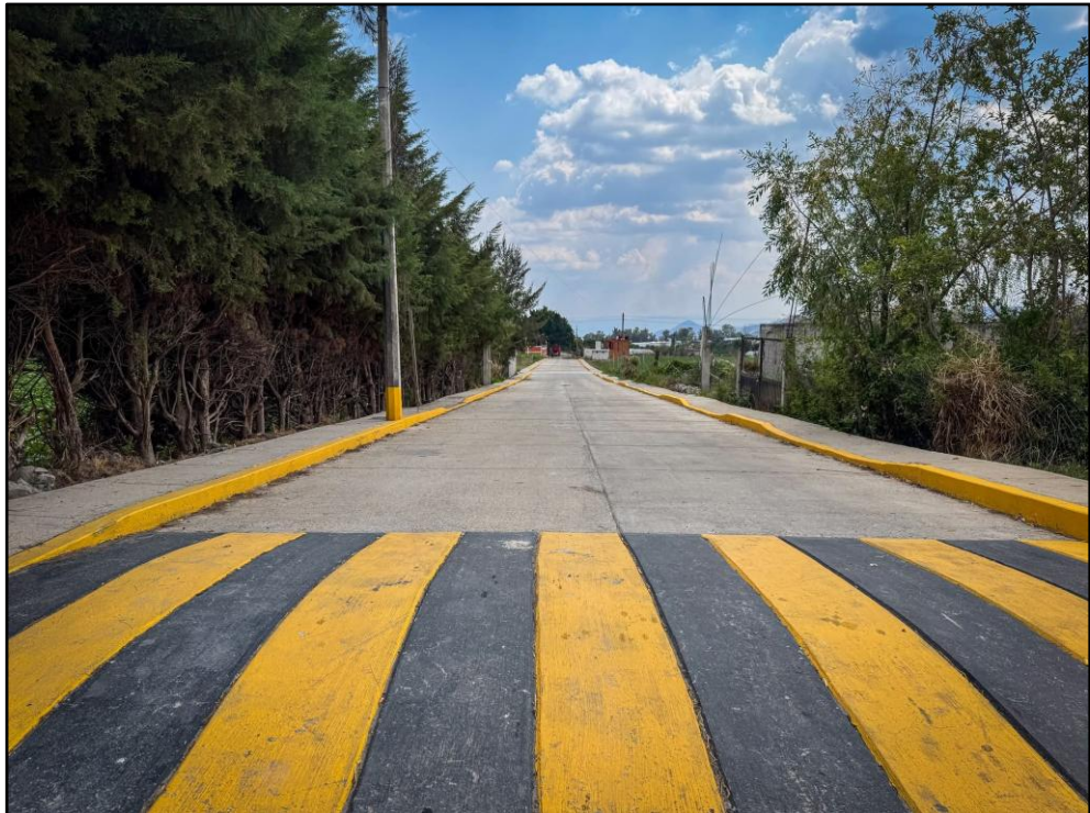
2.2.3. Pavimentación de calles en Zumpahuacán. .Fuente: Fotografía de la Coordinación Municipal de Protección Civil (2026).
