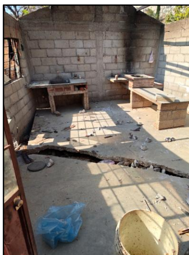
Ilustración 5.1.3 Inestabilidad de laderas en Santa Catarina. .Fuente: Fotografía de la Coordinación Municipal de Protección Civil (2026).
