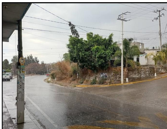
Ilustración 5.2.1 Lluvias en el municipio. Fuente: Fotografía de la Coordinación Municipal de Protección Civil (2026)
