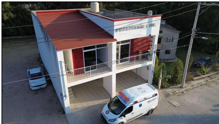
Ilustración 4.4.7 Protección Civil Municipal. Fuente: Fotografía de la Coordinación Municipal de Protección Civil (2026).
