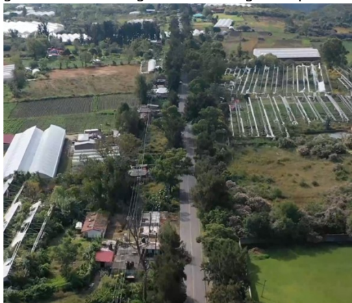
Figura 60. Vialidad regional Tenancingo-Zumpahuacán.
